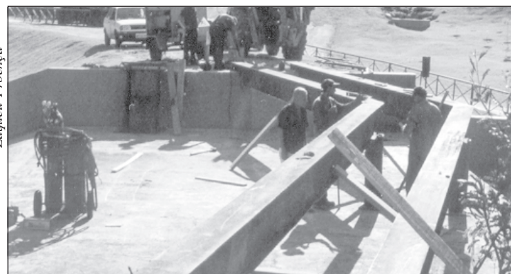
Funcionários do Saae concluíram a estrutura da ponte
