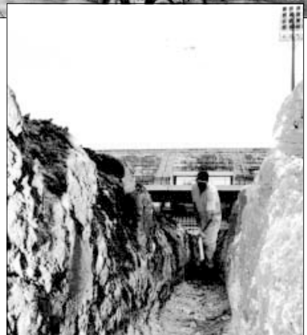
◀ Sobre as tubulações perfuradas será instalado um colchão drenador, que é composto de uma camada de 15 centímetros de pedra 2 e um filtro geo-têxtil, para evitar que os furos dos tubos entupam
