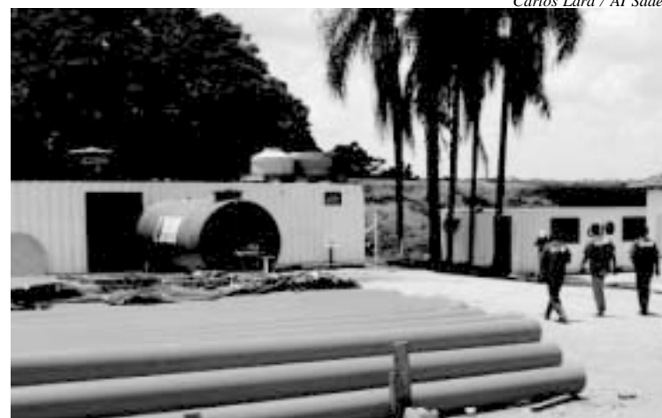
Obras incluem construção da ETE Aparecidinha e implantação de rede de esgoto e tratamento nos bairros Quintais do Imperador e Ipaneminha
