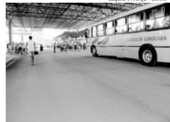
Os trabalhos consistem na recuperação do pavimento asfáltico e implantação de sinalização horizontal
