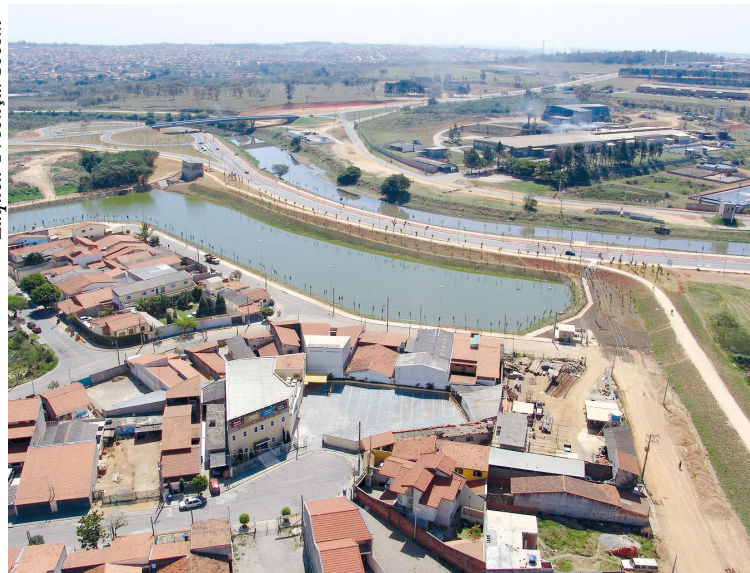
Sistema de Drenagem
