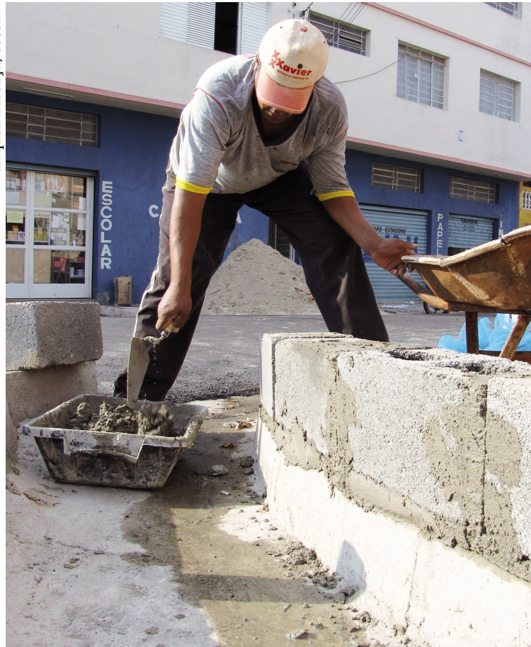
Operário trabalha no alargamento de calçada na avenida Nogueira Padilha.
