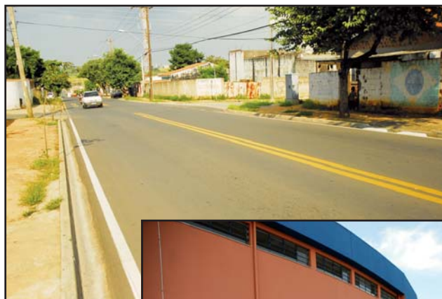
Pavimentação de várias ruas do Pq. Vitória Régia II.
