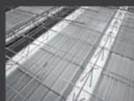
Lajes e Calhas
