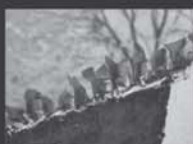
Cacos de Vidro nos Muros
