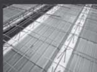
Lajes e Calhas
