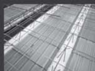
Lajes e Calhas
