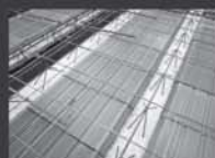
Lajes e Calhas
