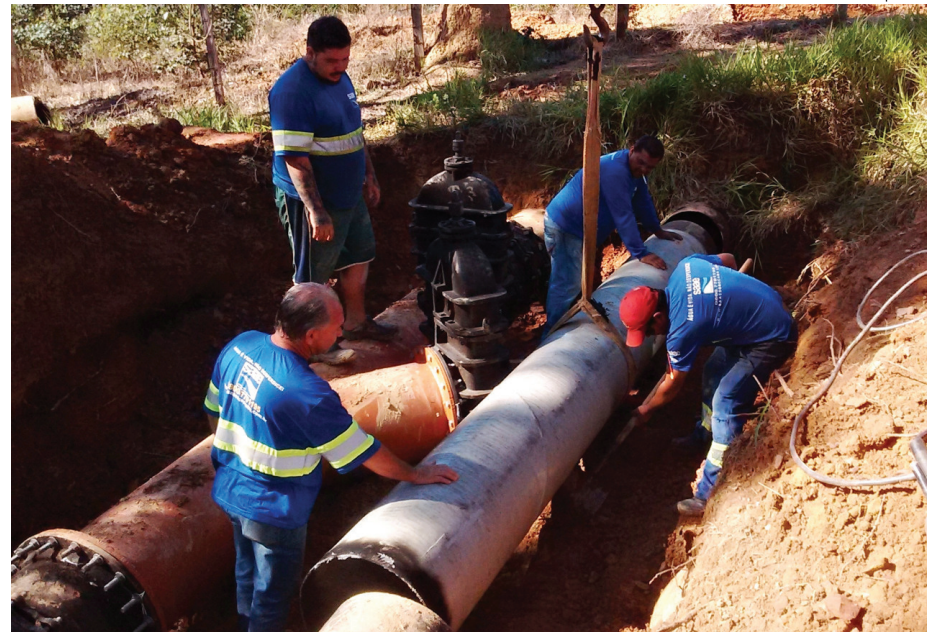
Adutora que vem sendo preparada para voltar a funcionar tem 500 milímetros de diâmetro e está desativada desde 2009
