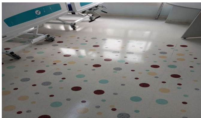
Remoção de sujidade por meio de limpeza mecânica aplicação de cera IMPERMEABILIZANTE (polimerização), instalação de barreira física (divisórias).
