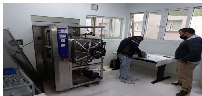
Manutenção de Autoclave - houve quebra do dispositivo de bomba d' água.
