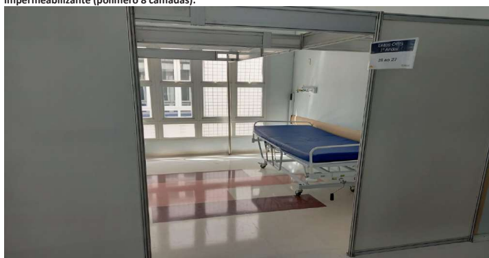
Unidades com instalação de rede elétrica, rede de gás medicinal, tratamento de piso adequado e barreiras físicas (divisórias removíveis)
