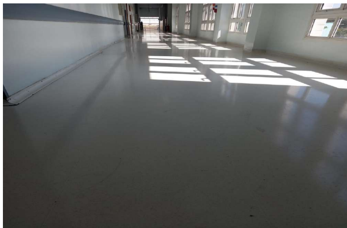
Piso corredor - processo de limpeza por meio de remoção de cera e posterior aplicação de cera impermeabilizante (polímero 8 camadas).
