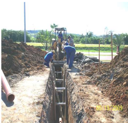
Exemplo de Escoramento – Bordas Limpas
